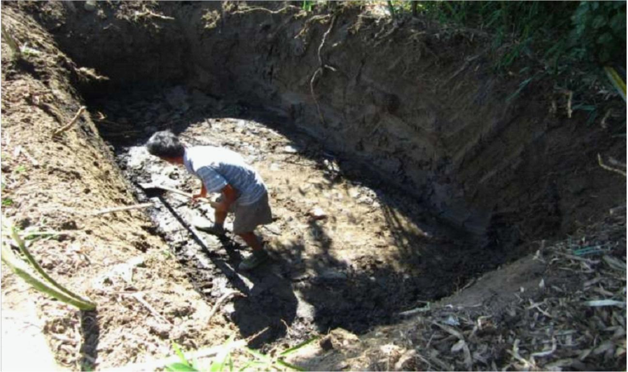
Encontrar todos os tubos de saída da casa e calcular a profundidade de escavação do STP. O tubo de entrada das águas residuais situa-se normalmente a 60 cm abaixo do solo, podendo ser reduzido de acordo com a situação atual
