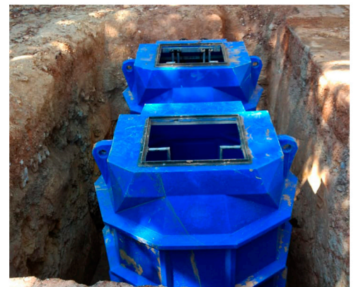
Posicionamento das elevatórias Aqualift 4500L.
