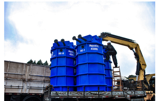
Transporte das elevatórias Aqualift 4500L.
